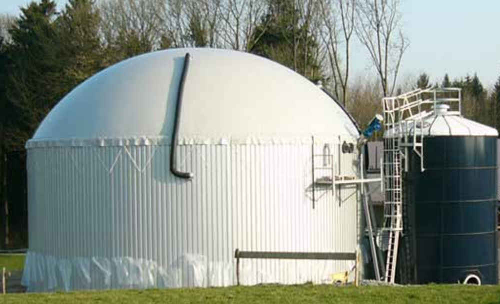
Couverture avec toit à double membrane pour l'intégration dans une installation de biogaz
