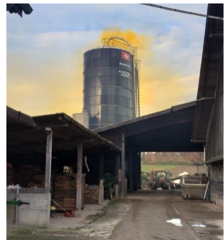
Abb. 2: Austreten des Nitrosengas
