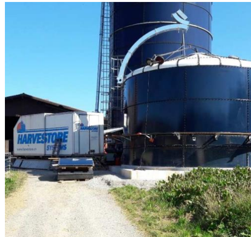
Abb. 10: Beginn Aufbau Harvestore mit dem Dach
