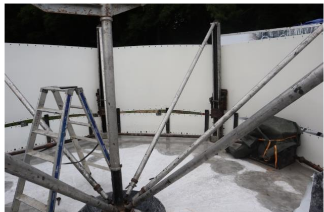
Abb. 7: Vorrichtung, um den Silo aufzubauen
