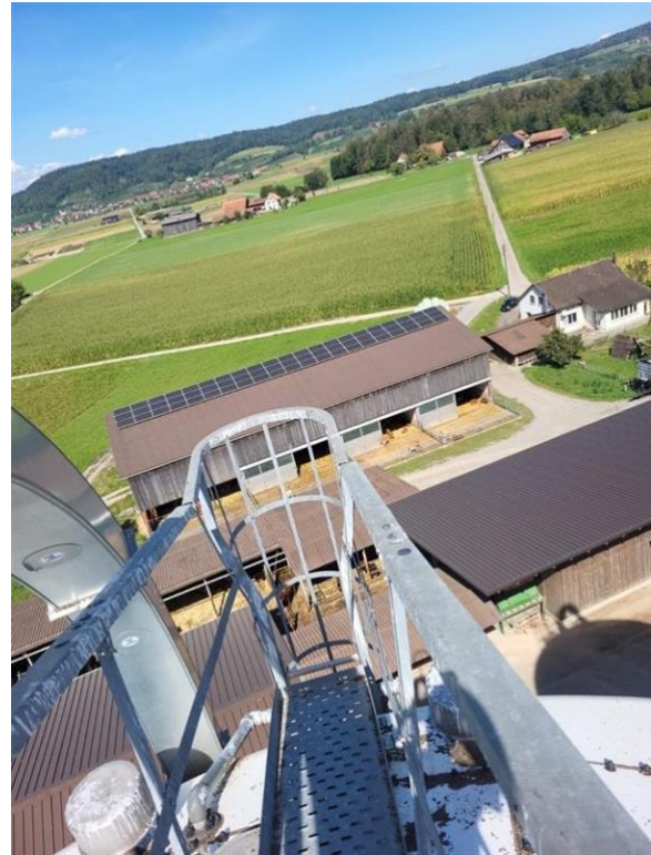
Abb.12: Sicherheitspodest auf dem Silodach
